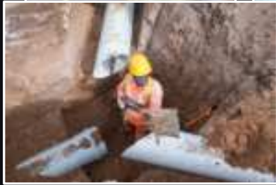
Obra Tunelera Liner - B° Las Delicias
