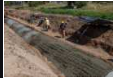
Nuevo Emisario - Obra de Newbery
